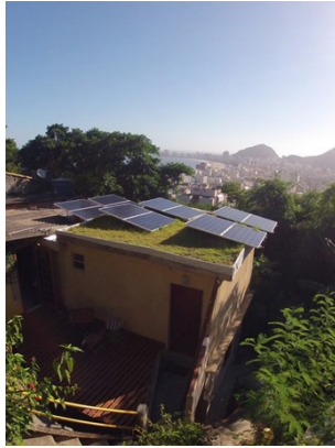
Figure 1-13 “ Estrelas da Babilônia ” PV power plant (2016).
