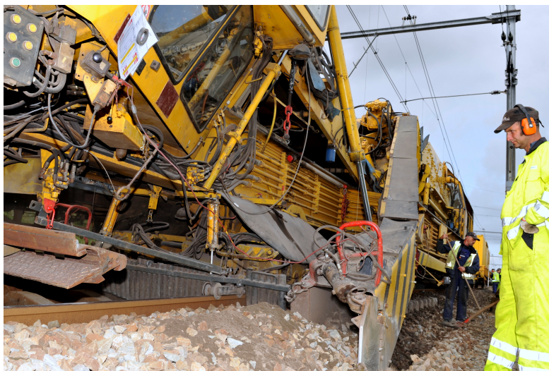
Figuur 4.1: Foto kettinghor in bedrijf, (van Zetten, 2020)
