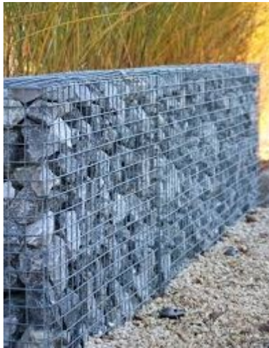
Figuur 6.2: Voorbeeld van een schanskorf (Kuhlkamp, g.d.)
