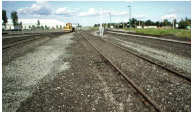
Figuur 7.1: Foto van spoor met metaalslakken in Canada (Hussain en Hussaini, 2022)
