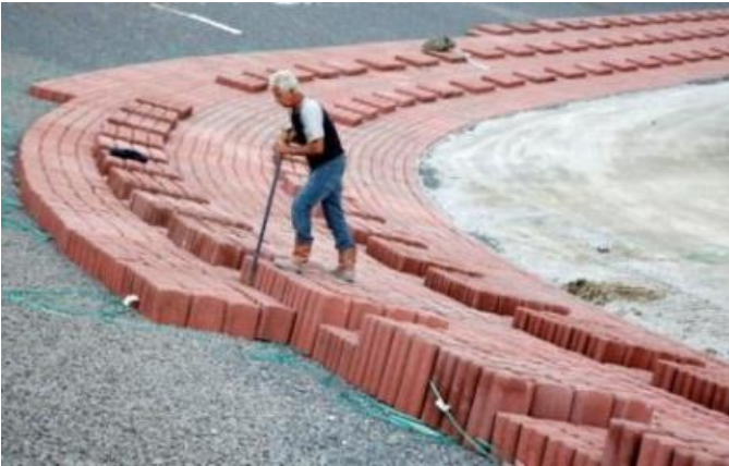
Figuur 1.2: Breskens; steenzetting in ribbenpatroon met veel openingen per rib en een grote afstand tussen de ribben
