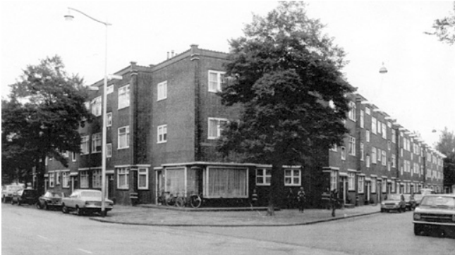
Figuur 23 Portiek etagewoningen
