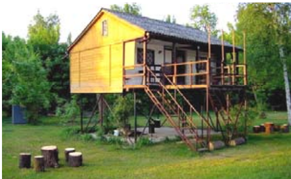
Fig. B6: Paalwoning op riviereiland in Belgrado
