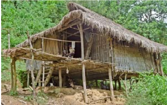
Fig. 3.27: Eenvoudige paalwoning in Vietnam
