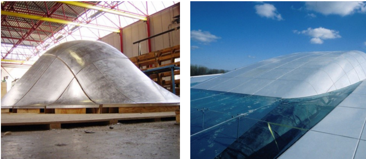
FIG. 7.8 Productie en montage van 3D vervormde aluminium panelen op holle mal explosief geperst Hoofddorp, zie 7.1.
