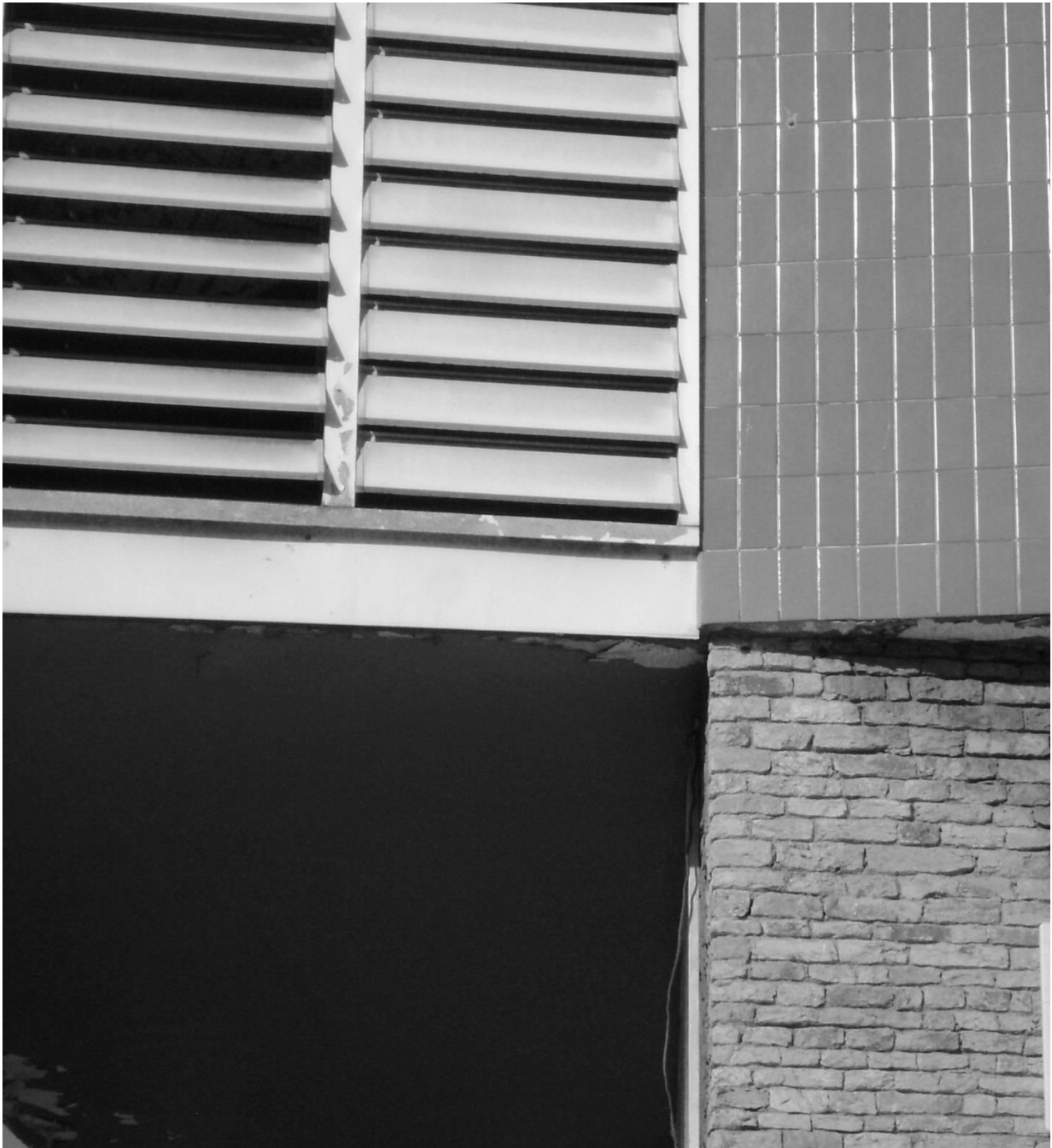
Image 1 José Antonio Corderch, Habitatges Barceloneta
