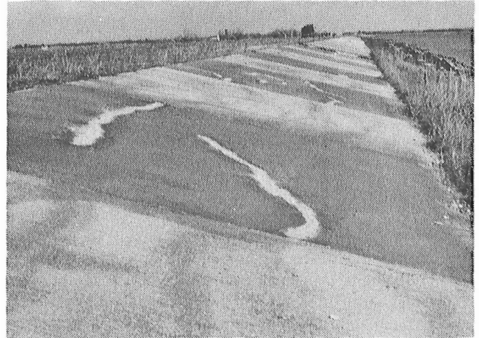
Figuur 10 gerestaureerde betonglooiing langs Limfjord in Denemarken.
