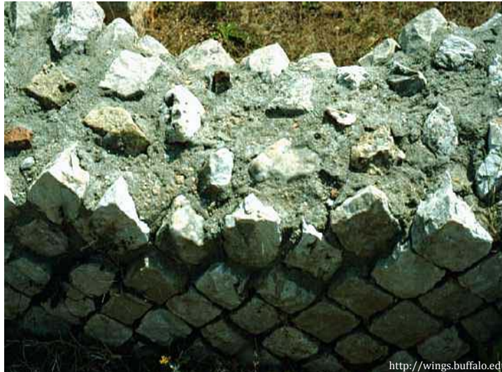
Detail van het muurtje/ dijkje van de rechthoekige vijver van Cavus Tiberius; Ze is gemaakt van diagonaal gestapelde gebakken steen met specie.
