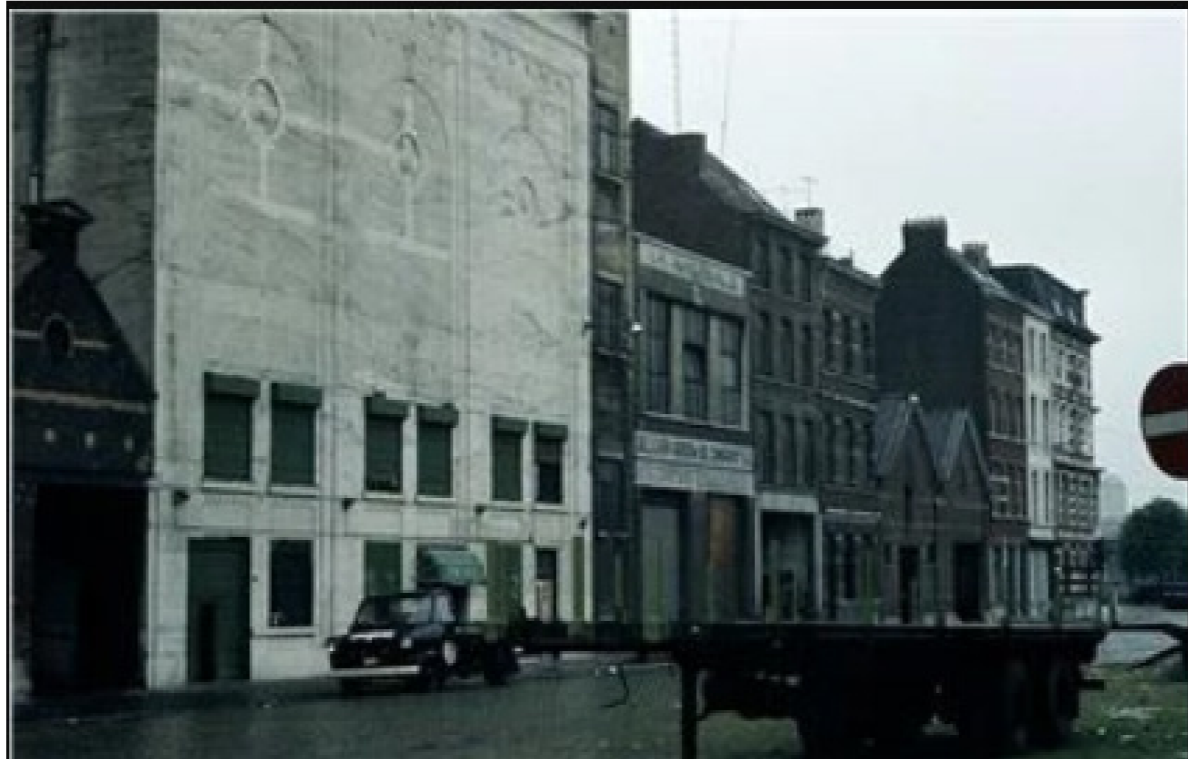
Warehouse La Nationale
