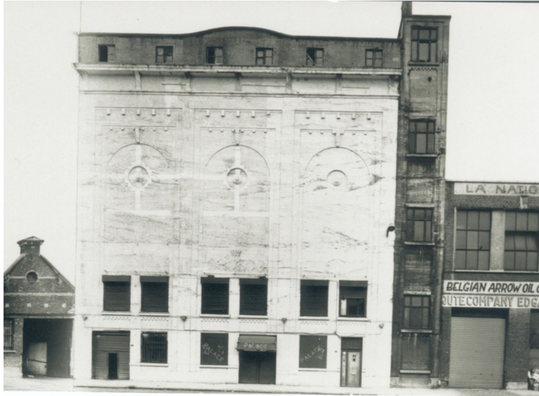
Warehouse La Nationale
