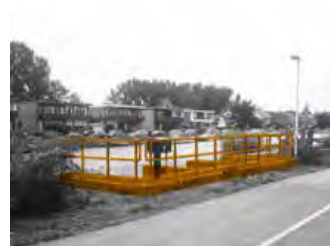
ILLUSTRATIE 3.46 Uitlaat: waterwerk dat aan de bovenkant van de dijk ligt en de plek versterkt waar het water, meestal onder de waterlijn, vanuit het gemaal in de boezem of het buitenwater stroomt.
