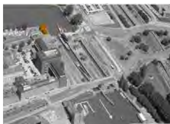
ILLUSTRATIE 4.34 Boezemgemaal Parksluizen en sluizen.
