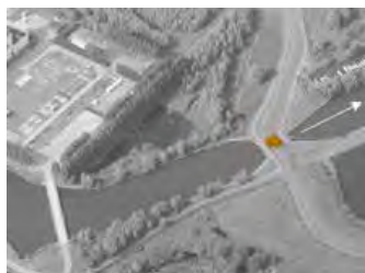
ILLUSTRATIE 4.27 Boezemgemaal/energiecentrale Diemen.
