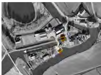
ILLUSTRATIE 4.38 Tussen-boezemgemaal Bovengemaal.
