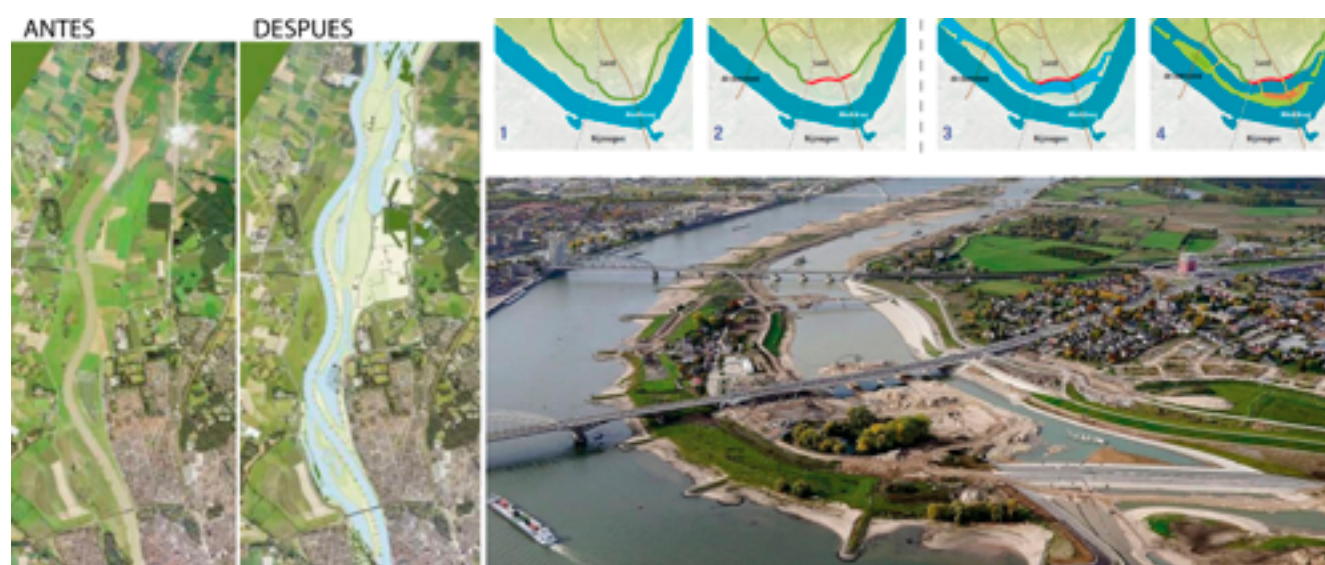
Figura 4. Nijmegen, obra del plan Room for the River, Países Bajos. Fuente: Rijkswaterstaat.
