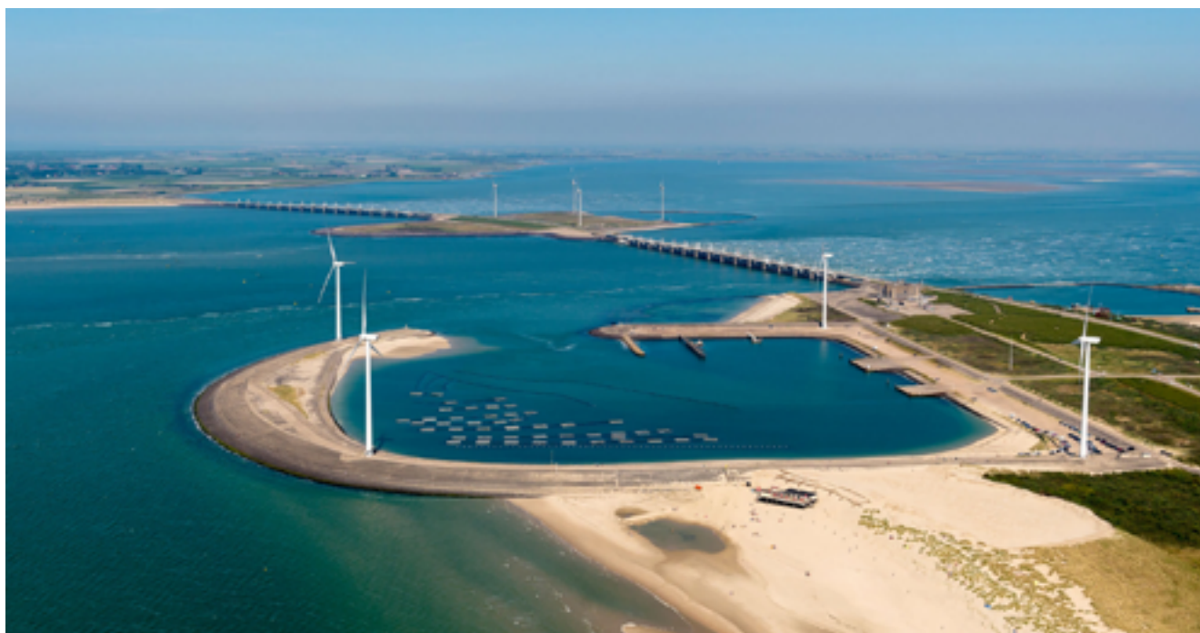
Figura 3. Eastern Scheldt Barrier, obra del plan Delta Works, Países Bajos. Fuente: Rijkswaterstaat.
