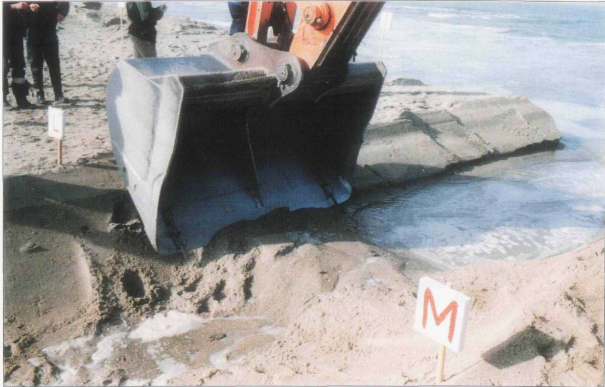
Figuur 16 Met behulp van een graafmachine wordt de initiële geul vrijgemaakt
