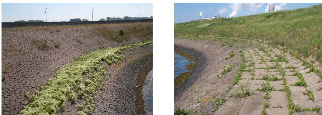
Figuur 25: Oeverbeschermingen aan de Noordzeezijde; zuidelijk (links) en noordelijk (rechts)
