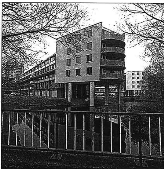
Afbeelding 4.1 Slaaghwijk na renovatie
