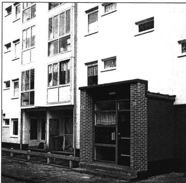
Afbeelding 5.11 Buitengevelisolatie met stucwerk aan de Zonzeelstraat in Amsterdam
