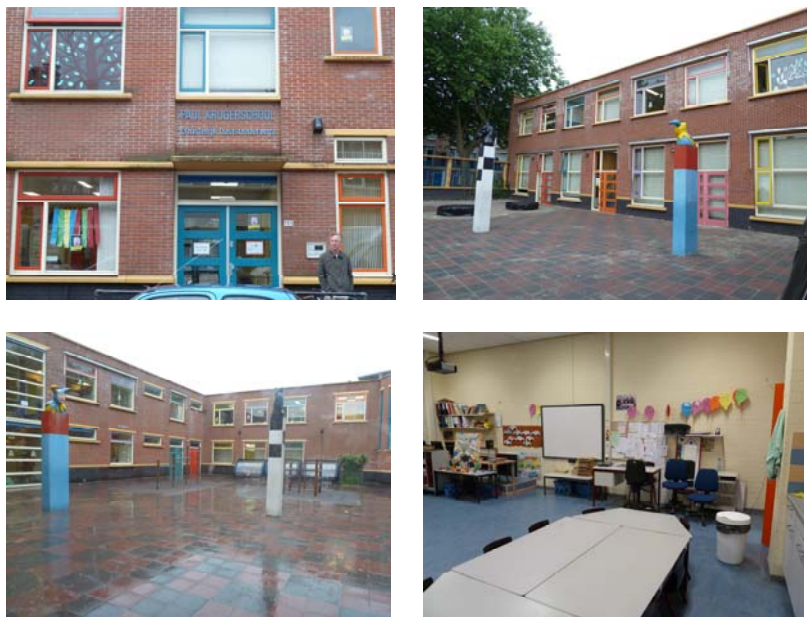
Figuur 78 Foto's van de Paul kruger school. Linksboven: Hoofdingang van de school. Rechtsboven: Gevel aan de binnenplaat (west-gevel). Linksonder: Gevels aan de binnenplaats(oost-gevel). Rechtsonder: klaslokaal.
