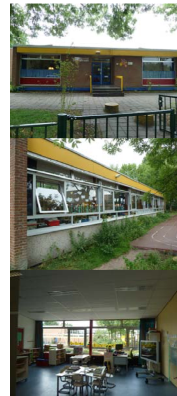
Figuur 5 Foto van het schoolgebouw
