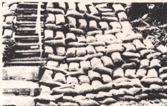
Blanket sand-cement bags, Conneaut, Ohio (Lake Erie).
