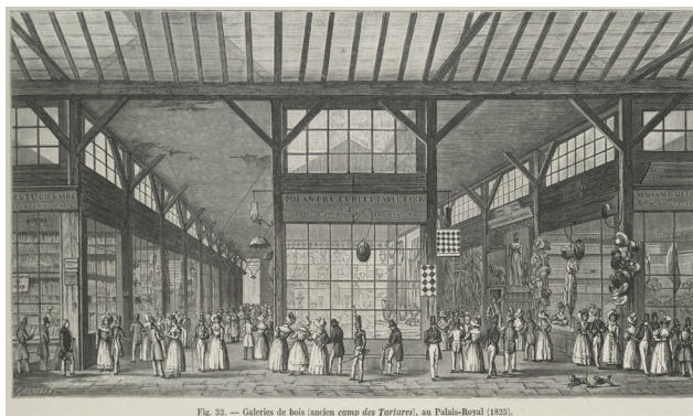
Fig. 33. — Galeries de bois (ancien camp des Tartares), au Palais-Royal (1825).
