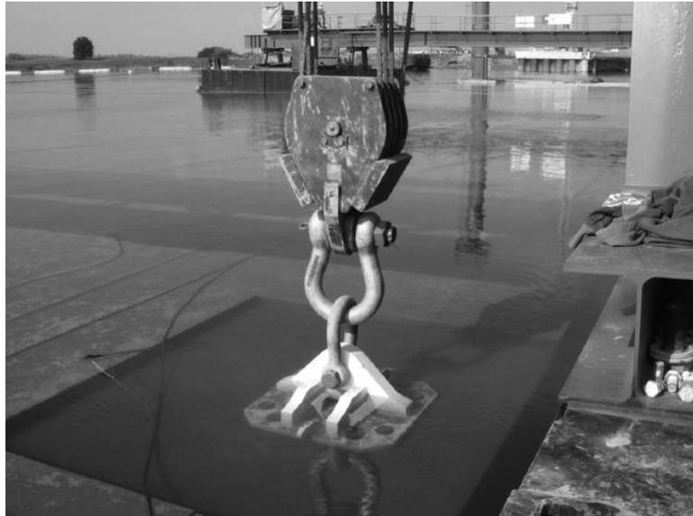
**FIGURE 14, HOISTING EYE ON TUNNEL ELEMENT (BABER & LUNISS, 2013)**
