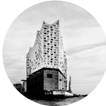
Elbphilharmonie - Herzog & de Meuron
