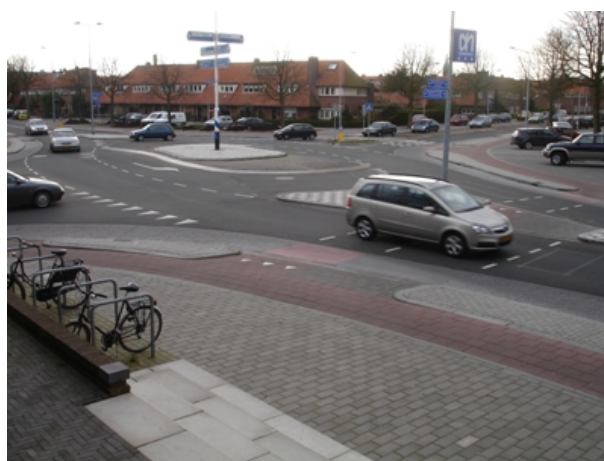
Figure 17: Voorrangsplein in the municipality of Hilversum (Gemeente Hilversum, 2012)
