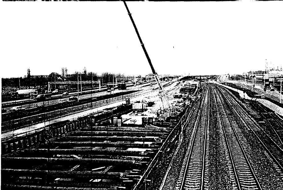
foto's: bouwterrein ingesloten tussen autosnelweg en spoorlijn, minimaal beschikbare ruimte op het maaiveld boven: startschacht Botlekspoortunnel /onder: toerit west Botlekspoortunnel
