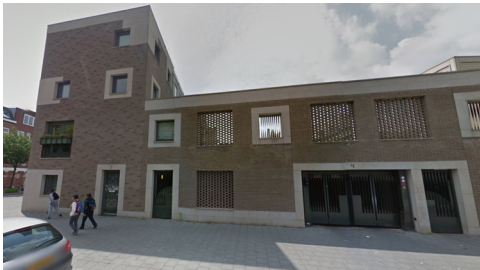
GARAGE ENTRANCE BLOKMAKERSSTRAAT
