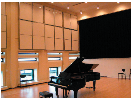
Figuur 6.4. Scharnierende panelen toegepast in een zaal van het Rotterdams Conservatorium.
