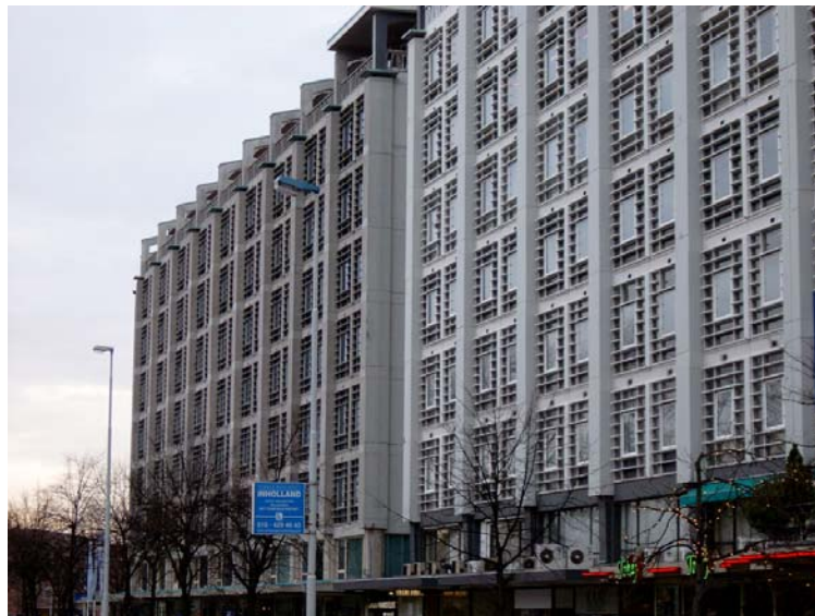
Afbeelding 2.1 Groothandelsgebouw aan het Weena in Rotterdam
