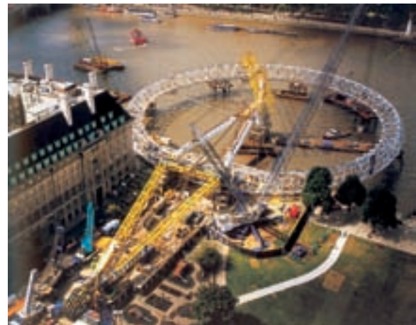
Overzicht assemblage plaats
