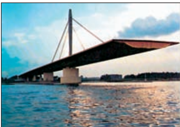
De brug Ewijk in vrije uitbouw.
