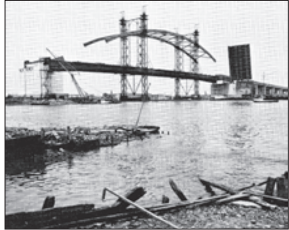
Montage Van Brienenoord Brug
