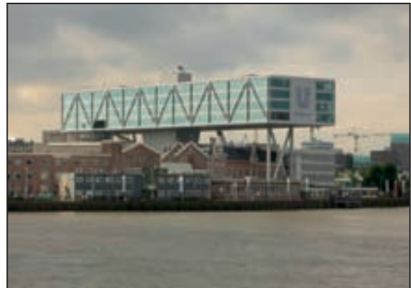
Verrijden en verschuiven van De Brug (Foto J. Berenbak)
