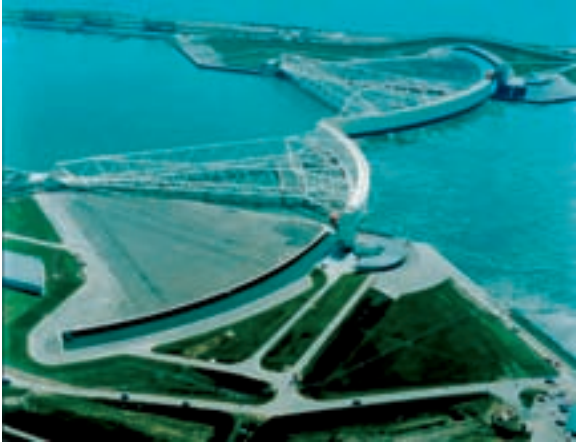
Maeslantkering in de Nieuwe Waterweg.
