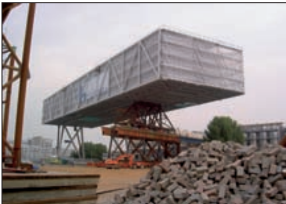
De Brug – Unilever Benelux (Foto J. Berenbak)
