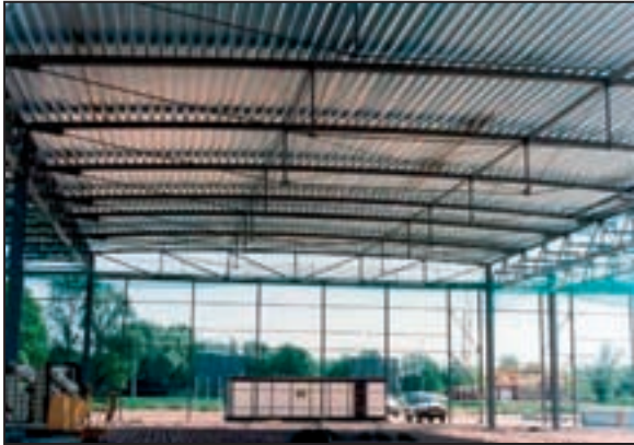
Constructie met stalen dakplaten
