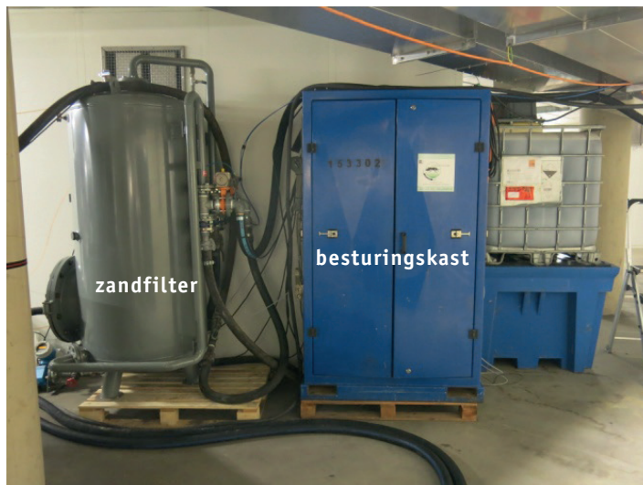
FIGUUR 2-5 NAGESCHAKELD ZANDFILTER
