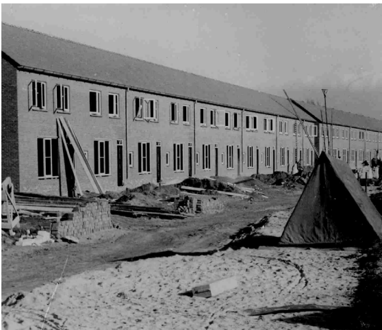
Fig. 25 - Fuutstraat during construction (Commissariaat van Politie Nijmegen, Afd. Fotografie, 1949)
