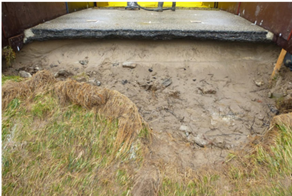
Figuur 4.13 Millingen, sectie 1. Asphaltverharding ondermijnd. Bezweken situatie.
