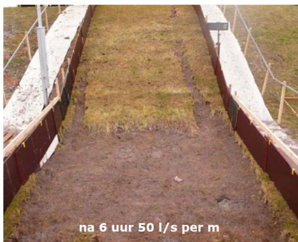
Figuur 3.4. Meerdere kale plekken op talud en gras verdwenen bij teen.
