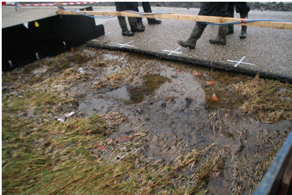
Figuur 4.7. Tholen. Sectie, buitentalud. Ondermijning en opdrukken asfaltberm. Einde proef. Eveneens meerdere plekken schade aan open talud.
