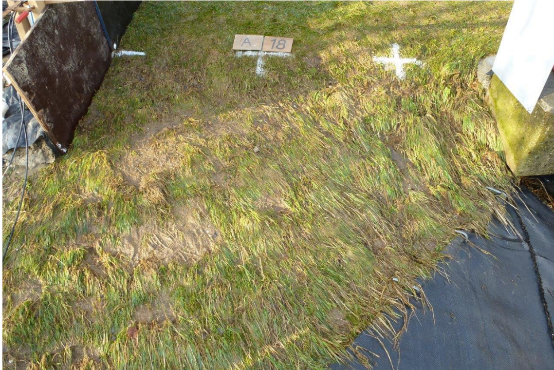
Figuur 4.12a. Nijmegen, sectie 2. Begin schade naast wand.
