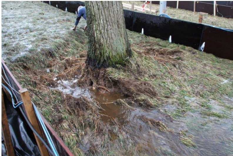
Figuur 4.5. Vechtdijk. Zeeregime met boom, proef 2; Gestopt, headcut erosie bovenstrooms van boom
