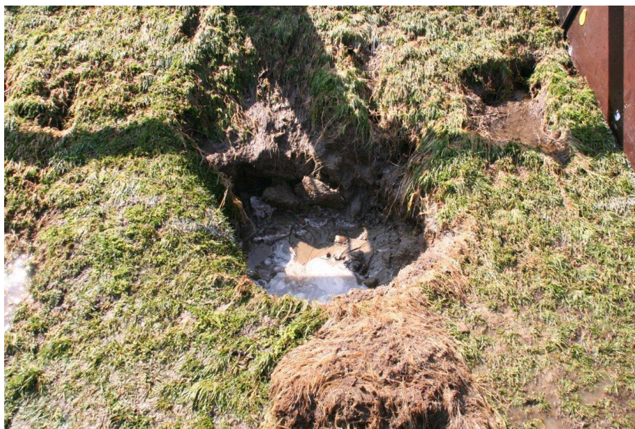
Figuur 3.4. Tholen, sectie 4, binnentalud. Bezwaken teen.
