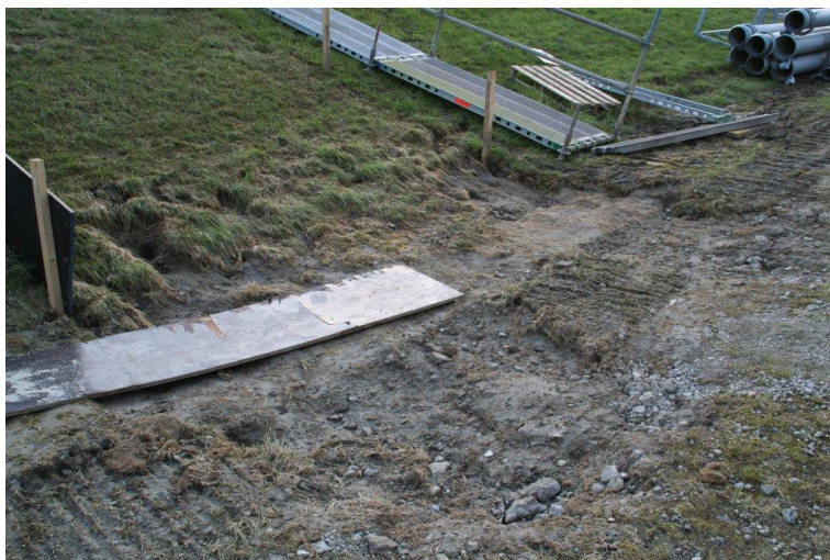
Figuur 3.3b. Kattendijke. Sectie 2. Benedentalud met teen, na de proef. De onderhoudsweg was afgedekt en kon niet worden beschadigd.
