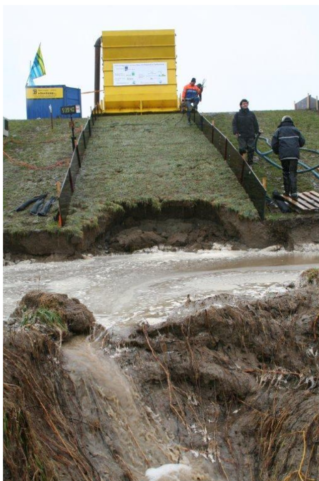
Figuur 3.3a. Kattendijke. Sectie 1. Aan het einde van de proef. Geen schade aan het talud, bezwijken van teen met onderhoudsweg, leidende tot headcut erosie op het talud.
