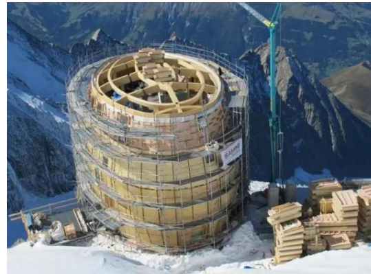
Figure 14. Construction of Refuge du Goûter. Groupe H
