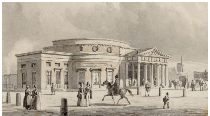
Figuur 8: Aanzicht noordoost zijde van het stationsgebouw: Willemspoor te Amsterdam Bron: (Stadsarchief Amsterdam, 1843)
