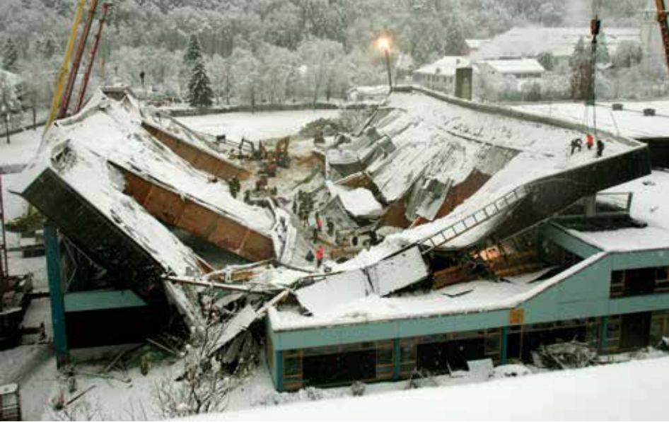
8 In 2006 bezweek het dak van de kunstijsbaan in Dab Reichenhall onder het gewicht van een laag sneeuw foto: AP Photo / Dieter Endlicher
