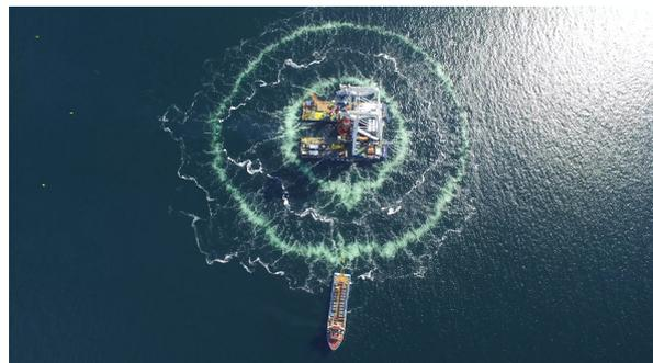
Figure 2.9: Bubble Curtain in Use (Hydrotechnik Lübeck GmbH, 2024)
