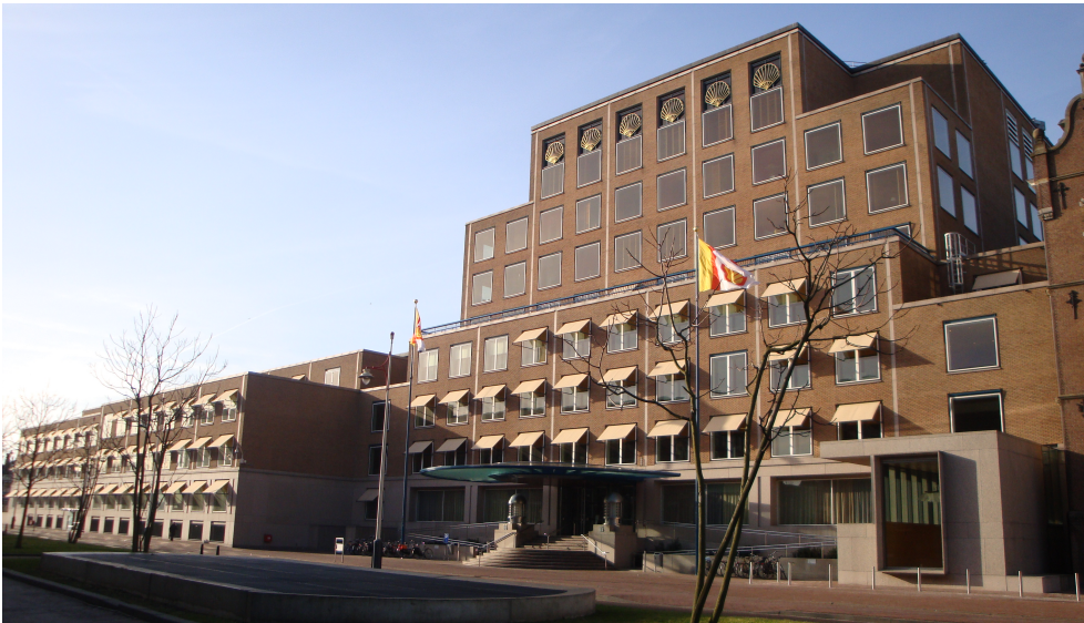
Figuur 6.29 C16, kantoor Shell (2012) (Bron: eigen foto, 2012)
