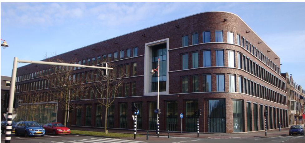
Figuur 6.30 C5, kantoor Shell (2012) (Bron: eigen foto, 2012)
