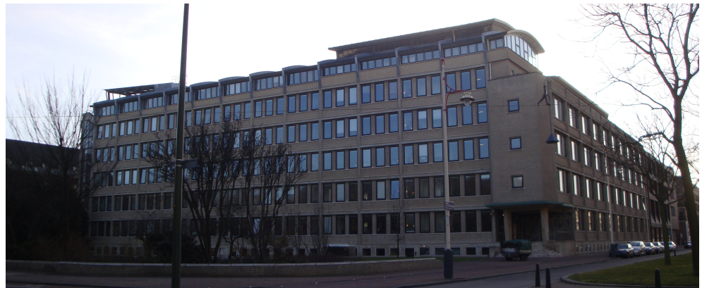
Figuur 6.25 C23, kantoor Shell (2012) (Bron: eigen foto, 2012)
