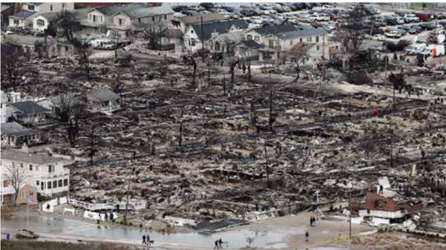
12 Damages in NJ © NYT
