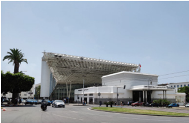
VUE SUR LA GARE ACTUELLE DEPUIS AV. MOHAMMED V
