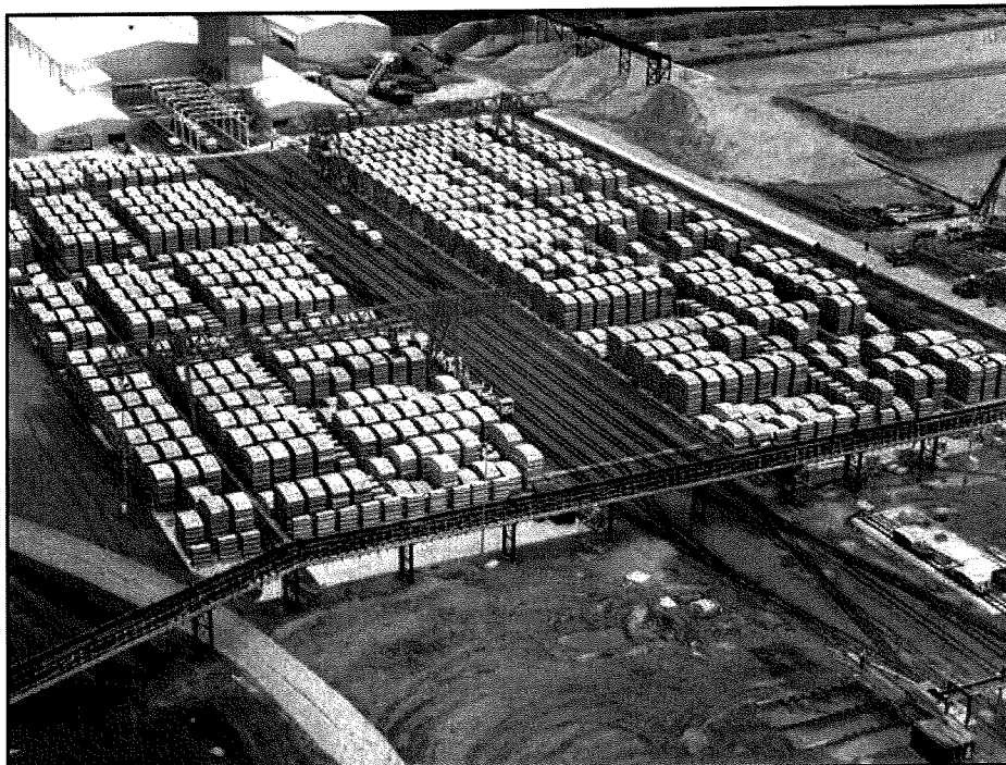
Figuur 6.2: Segmentopslag bij de Westerscheldetunnel (32).
