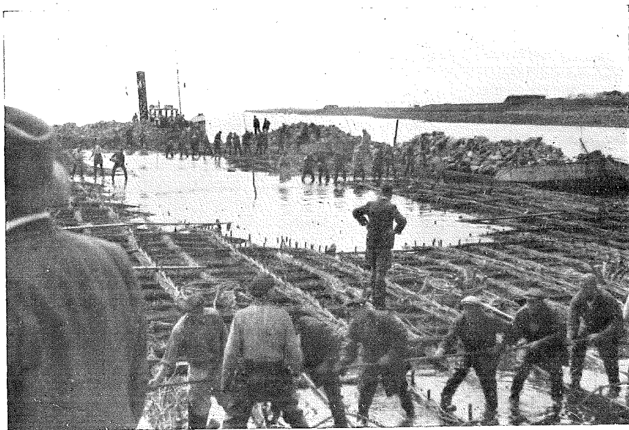
Foto 6. Gezicht op de werkzaamheden tijdens de voorbereidingen van het zinken. Op de voorgrond haalt een ploeg rijswerkers een tros wat door ten einde de ligging van het stuk te corrigeren. Verderop is men doende met het ballasten. In het midden is het gebalaste deel reeds onder water gezakt.
