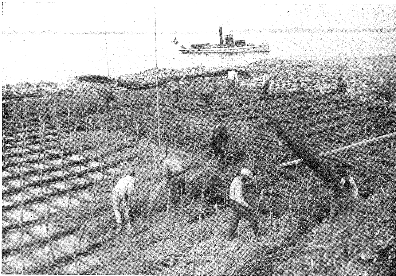
Foto 2. Het maken van een zinkstuk. Men ziet van links naar rechts het onderroosterwerk, een onderlaag van riet, de kruislaag en de deklaag van Gelders rijshout en het bovenroosterwerk met de betuining. Het afgebeelde zinkstuk wordt direct op de plaats van zijn bestemming gemaakt. Daardoor ziet men geheel rechts een gedeelte, waarop reeds steenballast is aangebracht.
