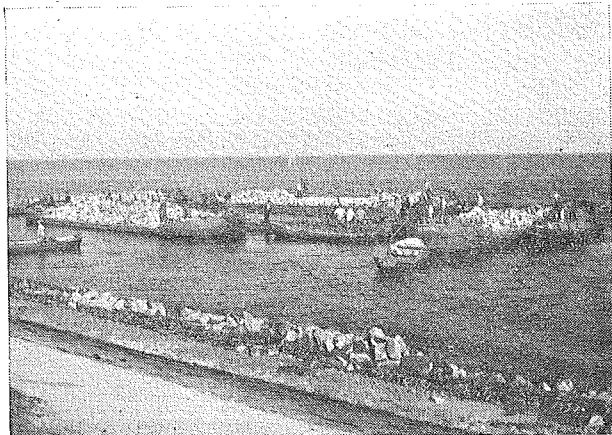
Foto 8. Gezicht op een zinkstuk tijdens de voorbereidingen van het zinken. Het stuk ligt in de raai; de steenbakken liggen er om heen; het stuk is in het midden reeds zo ver geballast, dat het daar onder water is gezakt.
