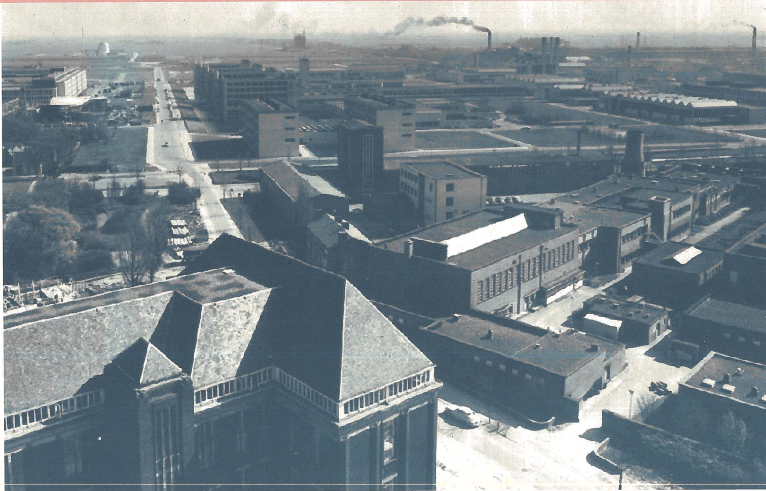
de Mekelweg in aanbouw, gezien vanuit Rode Scheikunde
