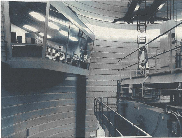
de oude regelkamer binnen de reactorhal
