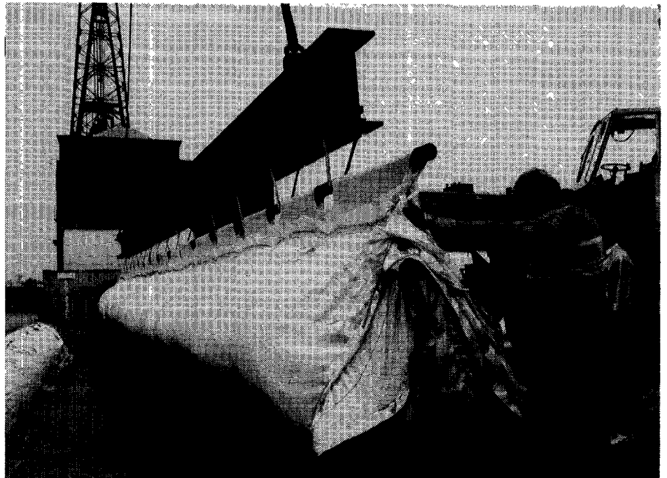
Het plaatsen van het proefslibscherm.
