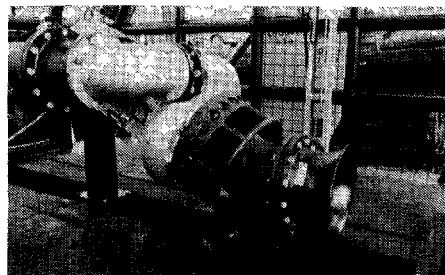
De pomp van het stationair zuigsysteem.
