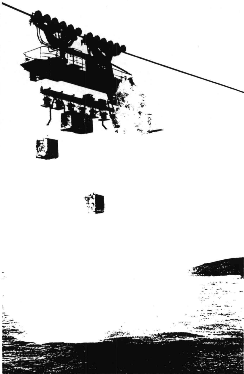
lossende gondel boven het zuidelijk sluitgat
