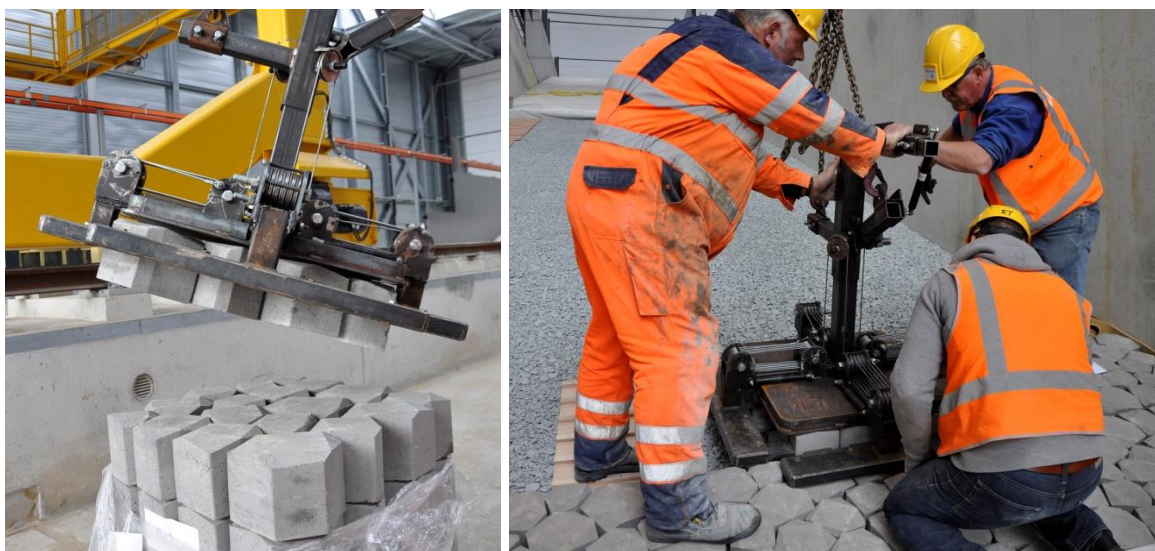
Figuur 3.6 Plaatsing van de Basalton 30 STS+ zuilen op de filterlaag met de speciaal daarvoor door Holcim Coastal BV gemaakte klem.
