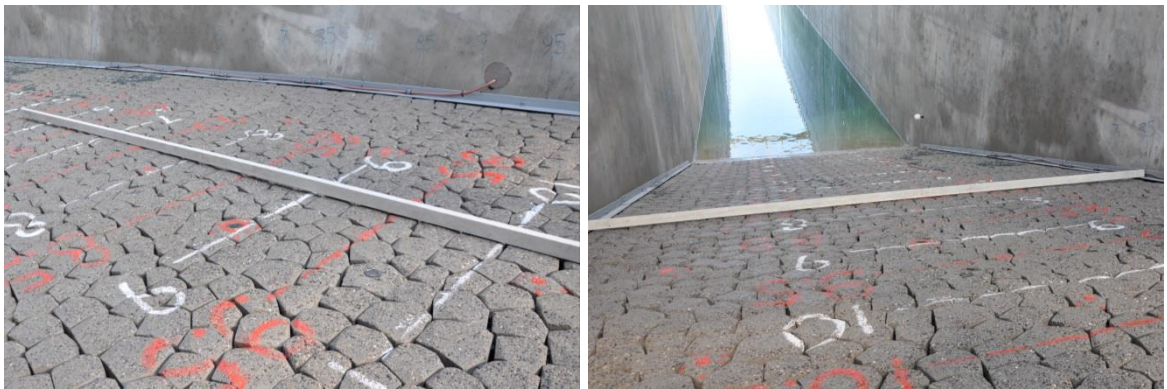
Figuur 4.11 Vervorming van de steenzetting na proef B10, zichtbaar met behulp van een balk langs het talud (links) en dwars op het talud (rechts)
