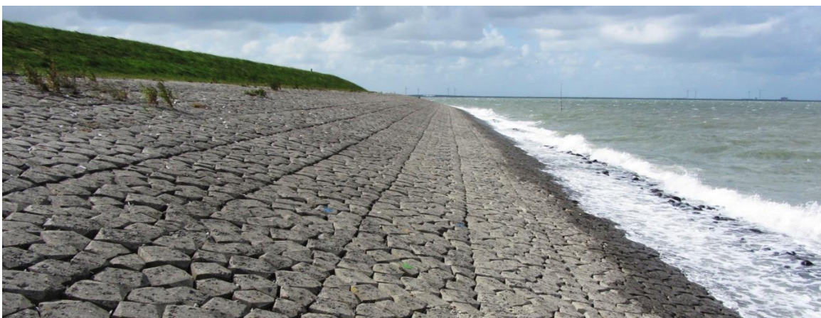
Figuur 1.2 Een steenzetting van machinaal geplaatste standaardsets (Basalton 30 STS+) op een dijk.
