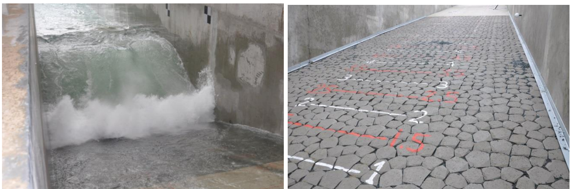
Figuur 4.5 Links: brekende golf tijdens proef B04. Rechts: de steenzetting na de proef B04 zonder zichtbare vervorming.
