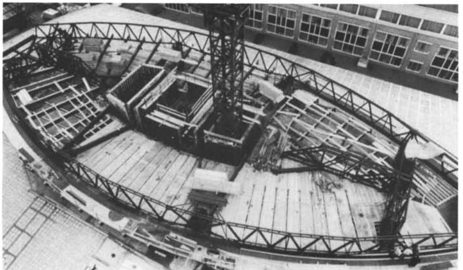
De uitvoering van de doos met de twee randbalken
