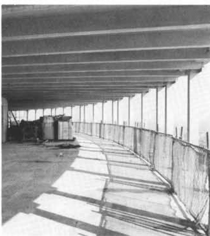
De uitvoering van de gevel
