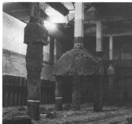
De uitgegraven fundering van de beurshalvloer
