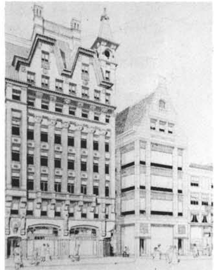
Gebouw 'De Utrecht' aan het Rokin in Amsterdam
