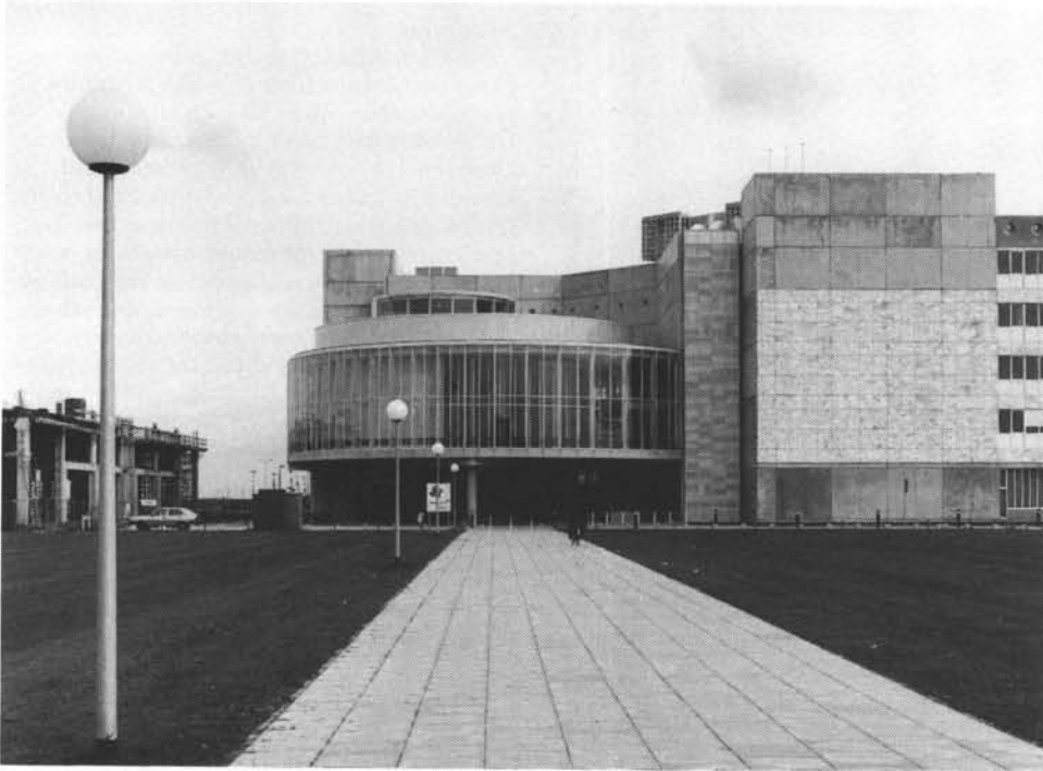
entree aan de stadzijde
