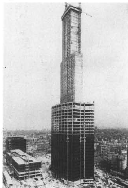
Kantoorgebouw Montparnasse, Parijs
