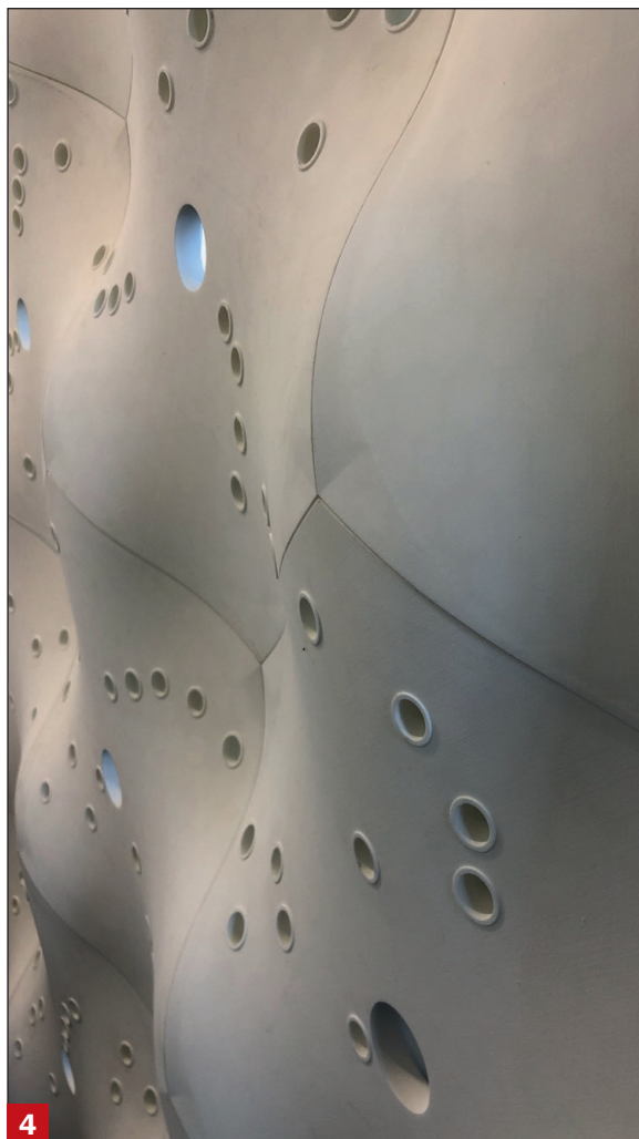
Geluidabsorberende wand op basis van kwart-golfenlengte-buizen, ontwikkeld binnen het ADAM project aan de TU Delft.
