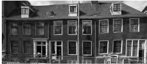
(a) building in Vijzelgracht, Amsterdam
