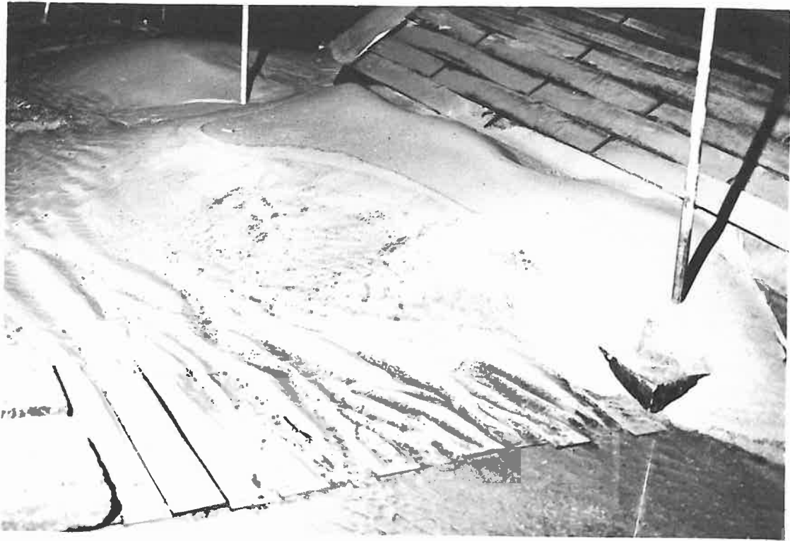
③ SITUATIE MET TALUD 4:1 NA DE PROEVEN
