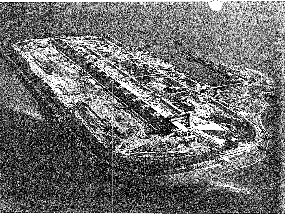
Het betonwerk van de sluis is gereed; met de montage van de 34 stalen segmentschuiven kan een begin worden gemaakt.
