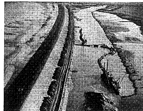
Situatie 3. Maken van de Zuiderdiepboezem (foto rechts). De specie werd in de op de tekening aangegeven plaatsen geborgen.
