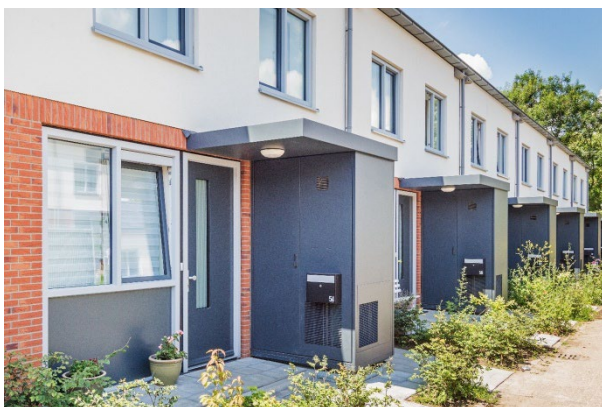
Figure 86. Presikhaaf NOM energymodule
