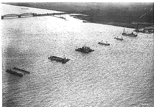
De Moerdijkbrug in aanbouw, voltooid in 1936.
