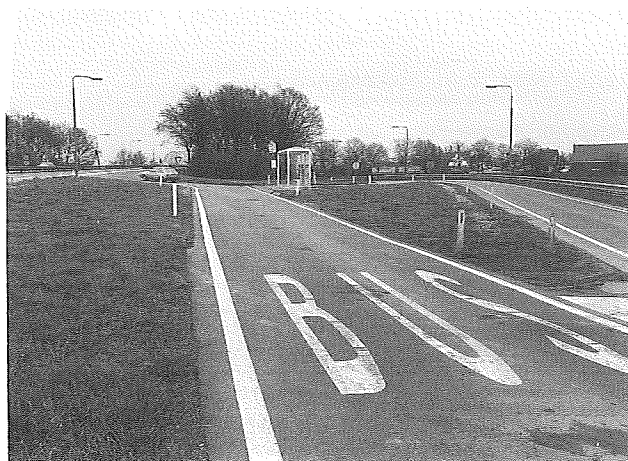
Busbaan bij Hendrik-Ido-Ambacht, 1989.
