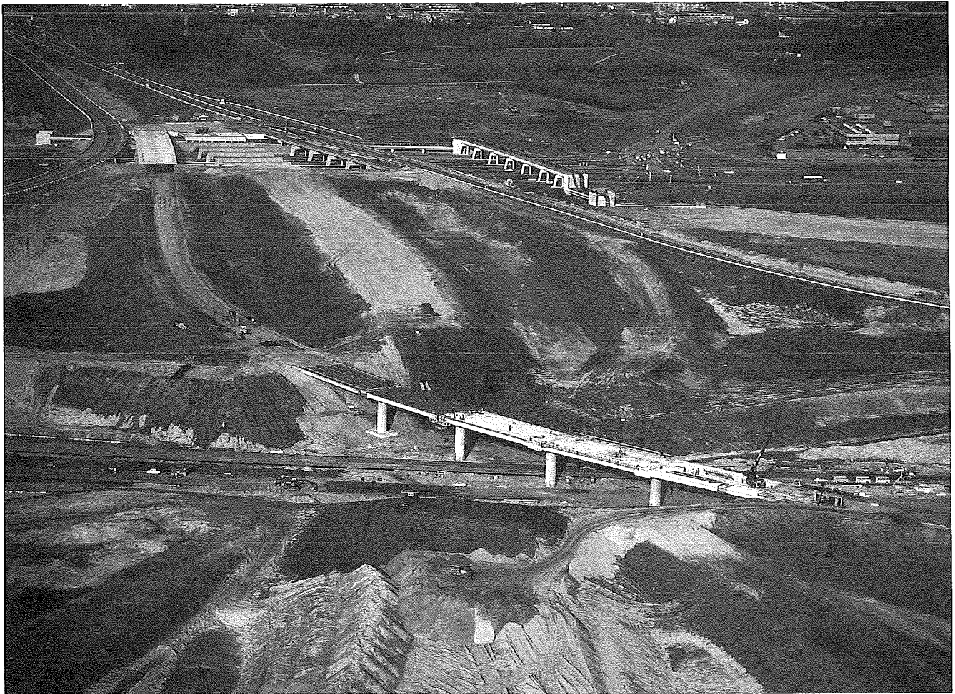
Bouw Sterplein Rotterdam Hoogvliet, 1970-1973.
