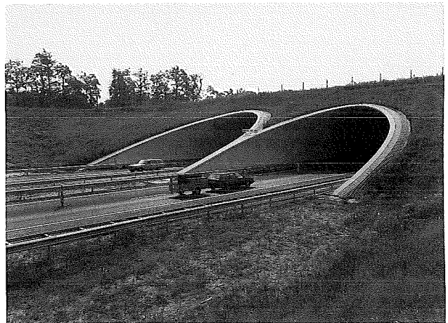
Wildviaduct „Woeste Hoeve”, 1988.
