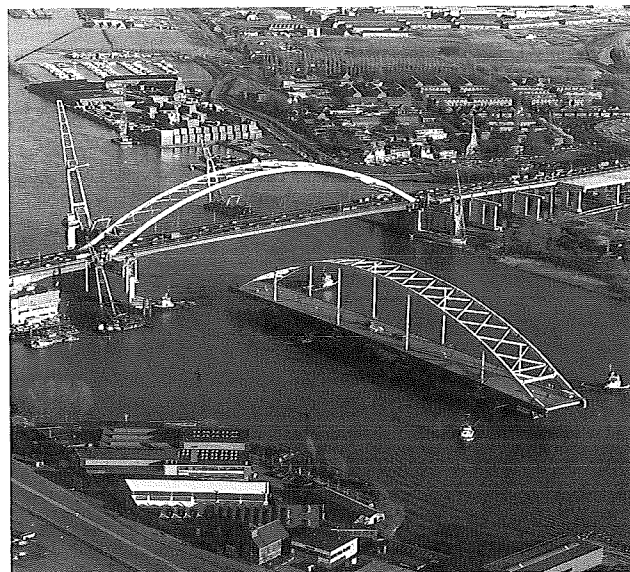
Invaren tweede deel Brienoordbrug, 20 februari 1989. De Brienoordbrug is één van de grote verkeersknelpunten die wordt aangepakt.
