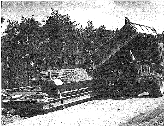
Storten van onderlaagbeton, rijksweg 12, 1956.
