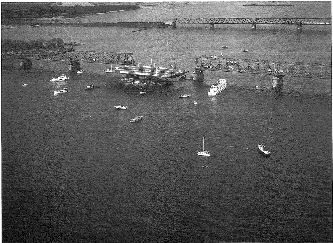
Moerdijkburg, vervangen van brugdelen, 1977.
