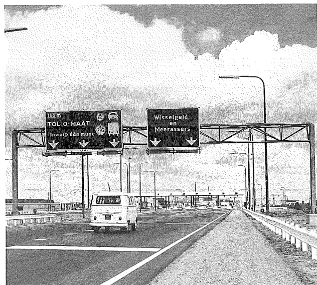
Tijdelijke tolheffing Beneluxtunnel, 1967, om de financiering voor een snellere aanleg rond te krijgen.
