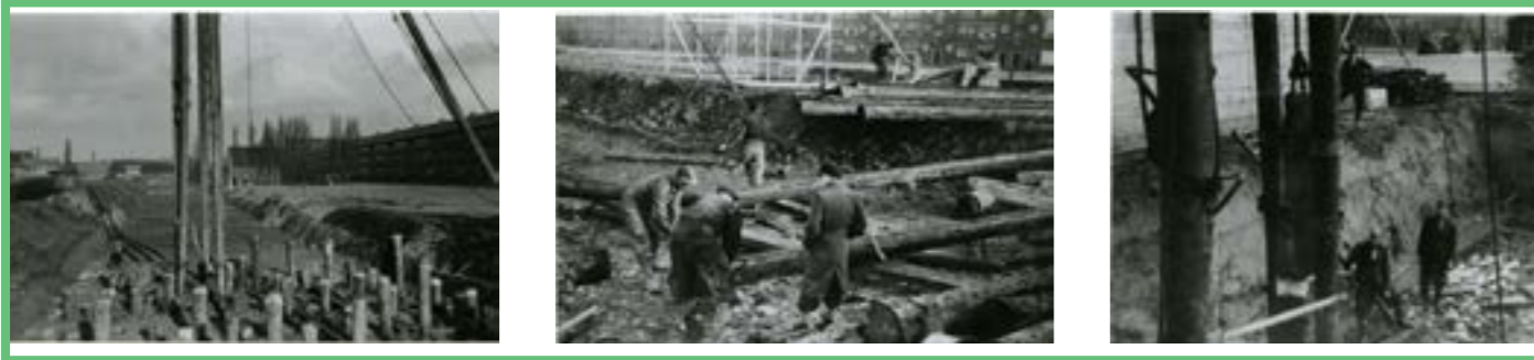
afbeelding 3.11 Foto's van de bouw van de Vogelbuurt, paalfundering. Historische stichting Charlois
